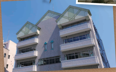
▼ 地下2階、地上6階の吹き抜け構造が特徴的な附属高校の校舎
