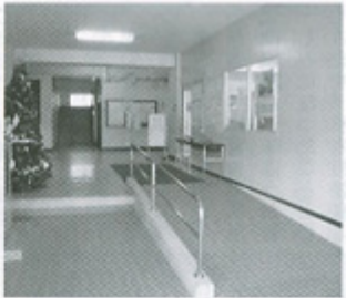
1号館玄関のスロープ
