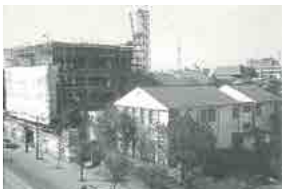
工事中の5階建て校舎（昭和39年10月）
